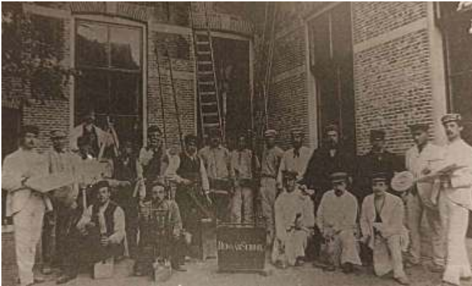
Sint-Antoniusgesticht in aanbouw Bron: Historische Kring Duiven-Groessen-Loo
