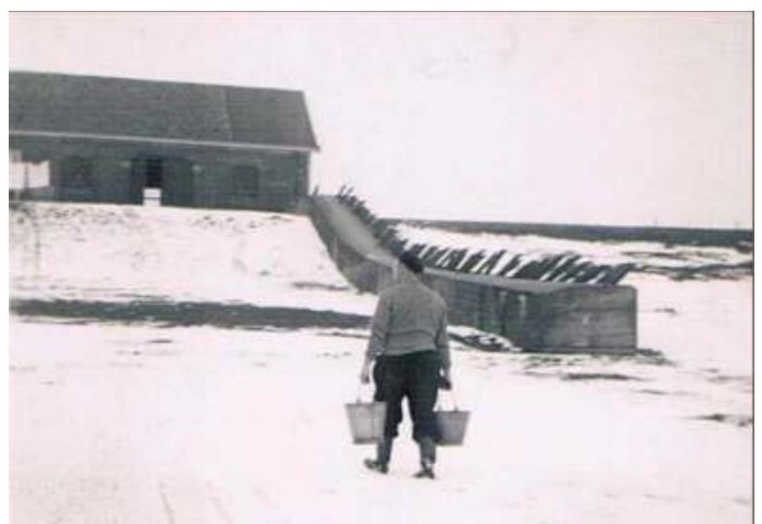
Tankversperring gelegen tegen het dijktalud aan de Leuvensedijk in Groessen. Gebouwd in 1939. Foto: HKDGL
