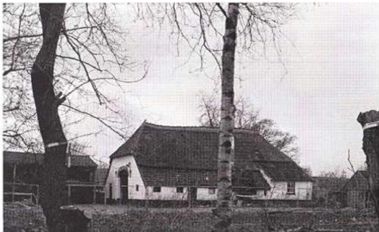
Foto 2 Rijksweg 15 van de noordzijde. Opmerkelijk is dat het bedrijfsgebouwtje (links) harmonieuzer is dan het woongedeelte (foto W.F.W.M. van Heugten, 2008).
